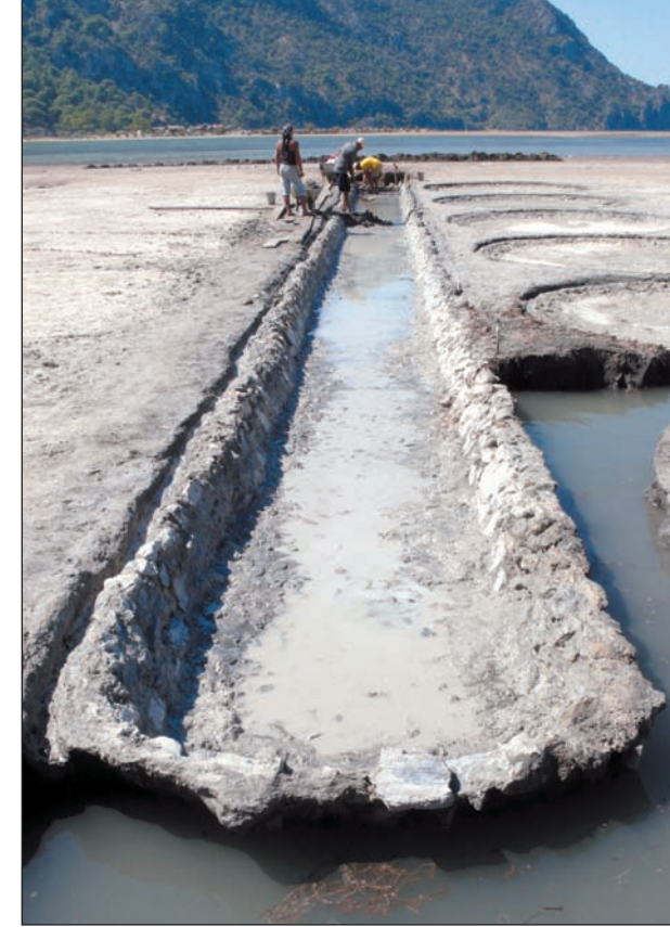
Yuvar örülerek yuvarlak kapatılmış kanalın arka dar kenarı...
