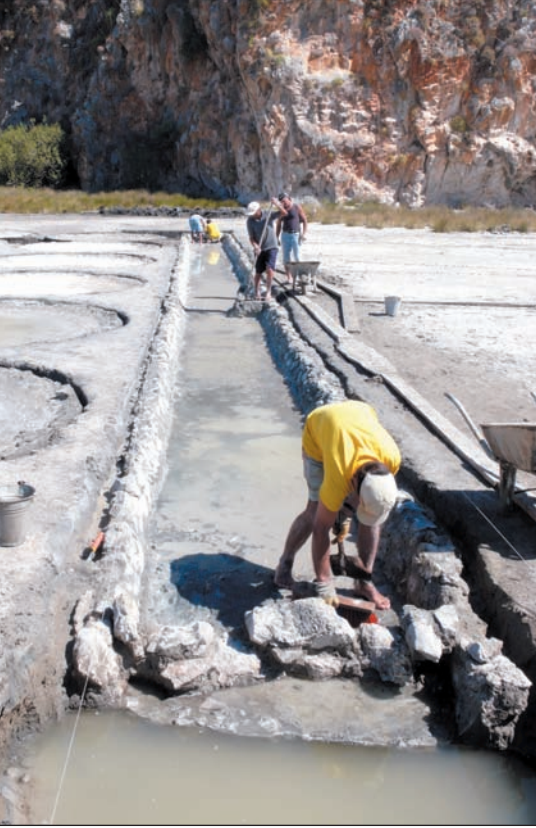
Kanalın kıyı şeridine açılan ağız ve deniz suyunun geriye kaçmasını engellemek için o dönemde alınmış olan önlem: Katarak.
