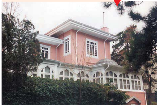
Özden İnönü'nün doğduğu Pembe Köşk
