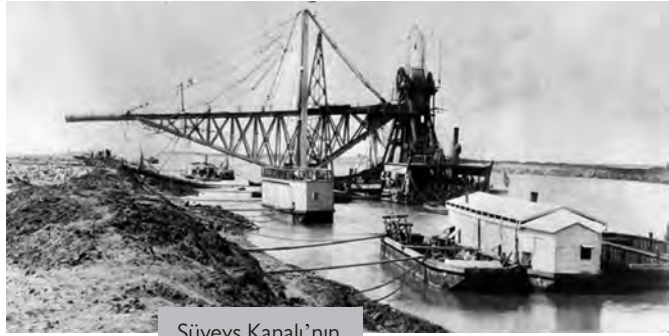
Süveyş Kanalı'nın yapım çalışmaları
