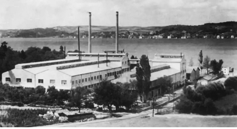
İstanbul Paşabahçe Şişe Cam Fabrikası (1934)
