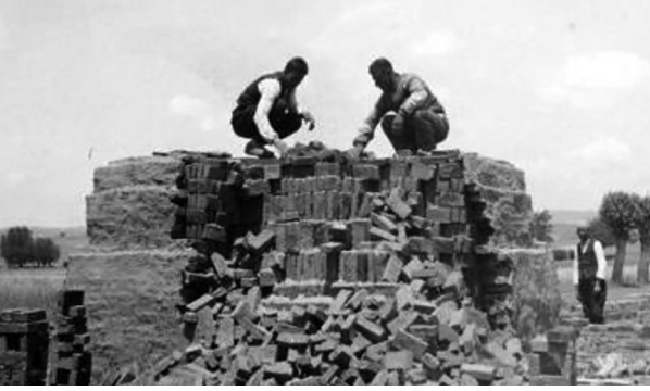
Gölköy'de Şekerköprüde yakılan tuğla harmanı
