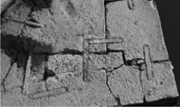
Meriç Köprüsü "selyaranı"nda taşların metal kelepçelerle birbirlerine bağlanarak mukavemetinin artırılması örneği
