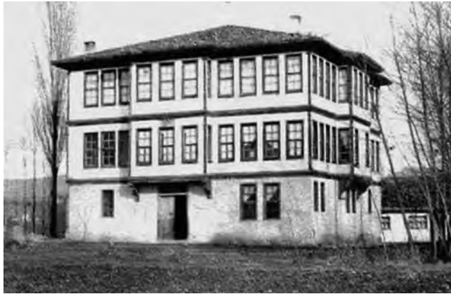
Gölköy Köy Enstitüsü’nün içinde öğretmenlerin de eğitildiği I numaralı binası
