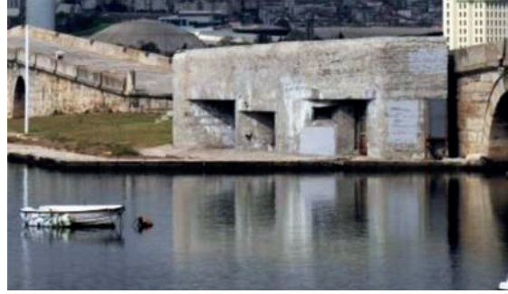
Çanakkale Boğazı'nda inşa edilen masif beton koruganlardan bir örnek.
