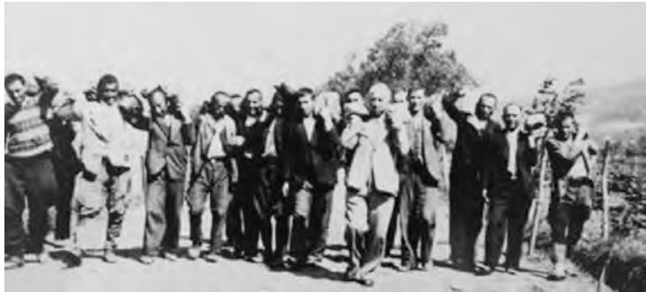
Eğitimci adayları öğretmenleriyle inşaata taş taşıırken (22.06.1939)
