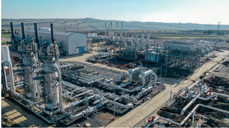
Sivilri Doğal Gaz Deposu, Marmara Ereğlisi LNG Terminalini barındırması açısından Marmara Denizi, stratejik ve ekonomik değer taşır.
